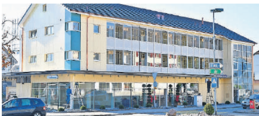
Das neu erbaute Kreuzcenter beim Kreisel in der Dorfmitte von Hägendorf. BKO
