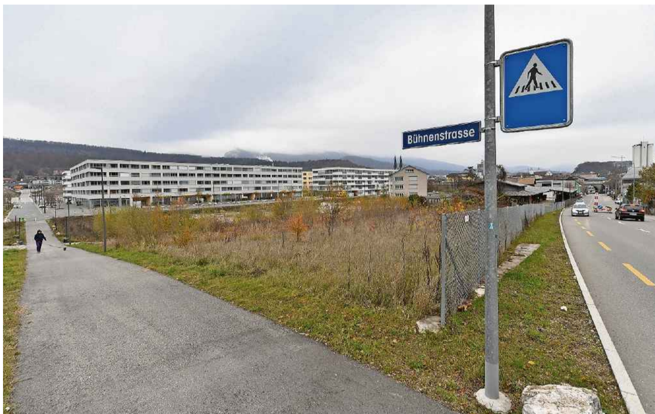
In diesem Bereich soll neu die Ein- und Ausfahrt in den Rötzmattweg zu stehen kommen, um mehr Stauraum vor dem Rötzmattknoten zu gewinnen. Zudem soll die Fahrbahn zum Knoten hin zweispurig geführt werden, um Rückstaus zu reduzieren. BRUNO KISSLING
